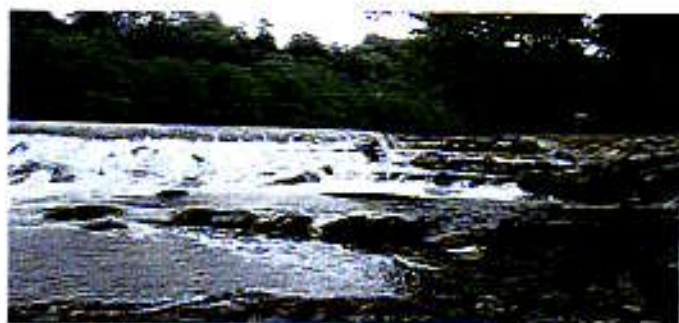
Levée des Frères : création d'une passe à poissons et d'une grille de désenvasement.
